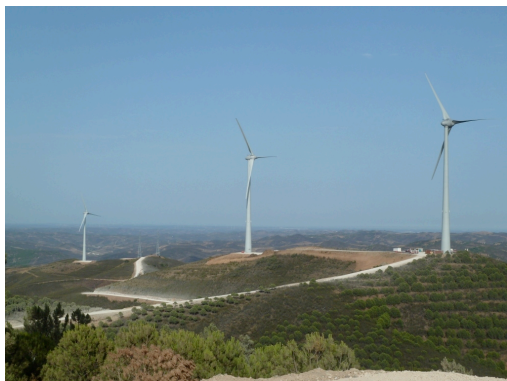
Parque eólico de Malhanito (ligado aos 60 kV na subestação de Tavira da REN)
