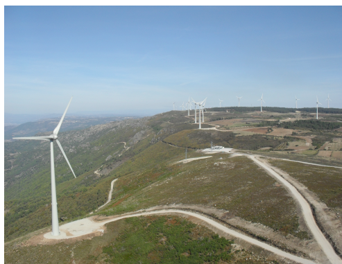
Parque eólico de Malhanito (ligado aos 60 kV na subestação de Tavira da REN)
