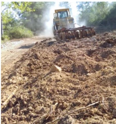
Gradagem, com grade rebocada para limpeza da vegetação espontânea
