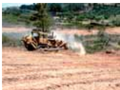
Figura 8 – Desmatação e decapagem.
