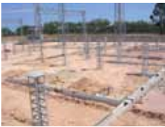
Figura 17 – Execução de caleiras e montagem de estruturas de suporte.
