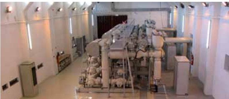
Figuras 2 e 3 – Fotografias de uma Instalação Blindada (GIS – Gas Insulated Substation ) – vista interior.
