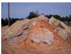
Figura 38 – Resíduos de betão, retirados do local de lavagem dos camiões betoneira, aguardando posterior encaminhamento.
