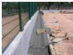
Figura 28 – Execução de valetas perimetrais.
