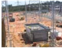
Figura 20 – Construção da Casa dos Serviços Auxiliares e do parque de AT.
