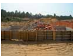
Figura 39 – Armazenamento temporário dos resíduos de tijolo.
