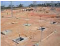
Figura 19 – Maciços para equipamento de painei de 400 kV.
