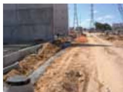
Figura 30 – Drenagem junto a maciço de transformador.
