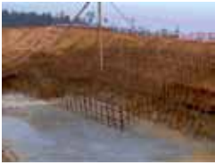
Figura 15 – Aplicação de armadura para sapata do maciço PAL4E.
