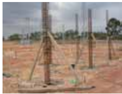
Figura 18 – Armaduras para pilares de Casa de Painei.
