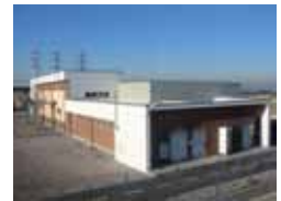
Figura 41 – Subestação em funcionamento.
