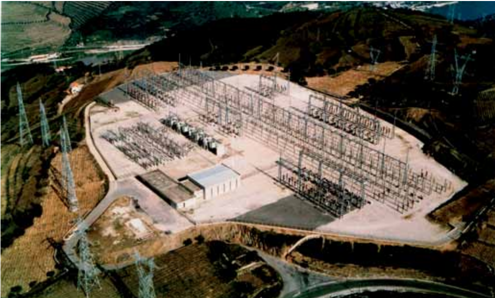
Figura 1 – Fotografia de uma Instalação Convencional (AIS – Air Insulated Substation ).
