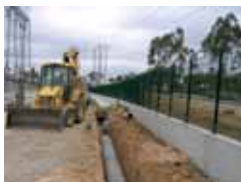
Figura 29 – Rede de drenagem: vala e colector.
