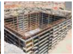
Figura 25 – Depósito de retenção de óleos em construção.
