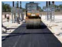
Figura 26 – Compactação de betuminoso em via de acesso aos disjuntores na subestação.
