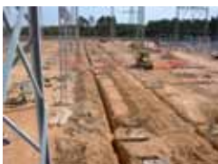
Figura 31 – Valas para rede de terras.
