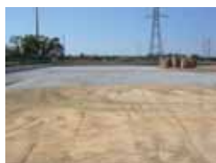
Figura 32 – Espalhamento de gravilha.
