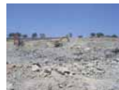
Figura 12 – Zona de escavação.
