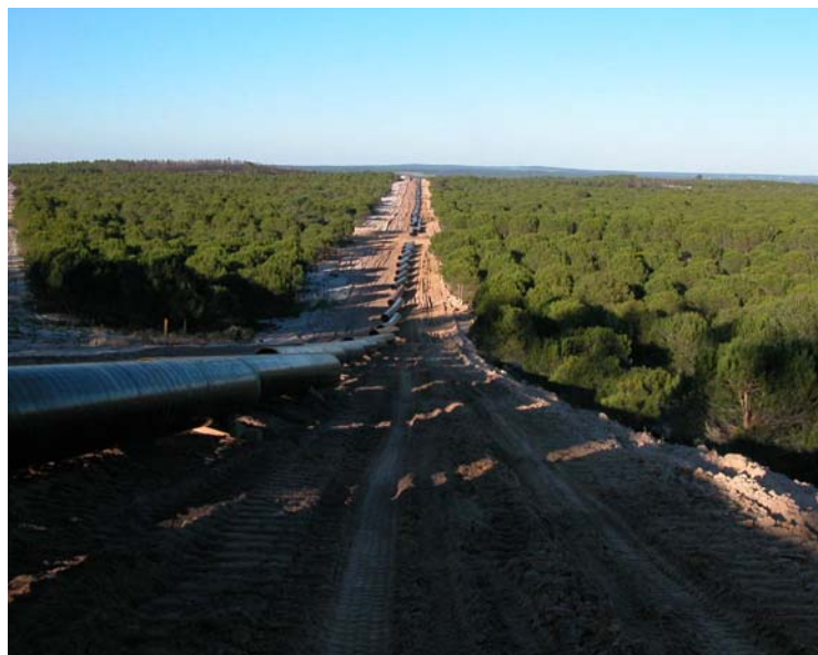
Construção de gasoduto
