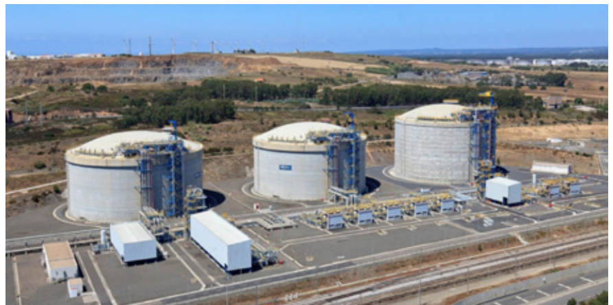
LNG TERMINAL Storage
