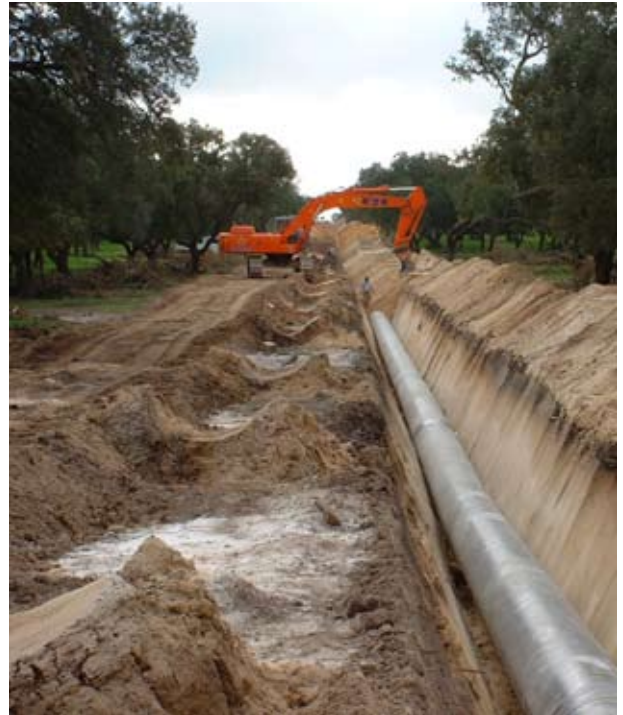
Construção de gasoduto
