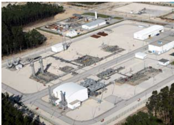
Vista Geral da Estação de Gás
