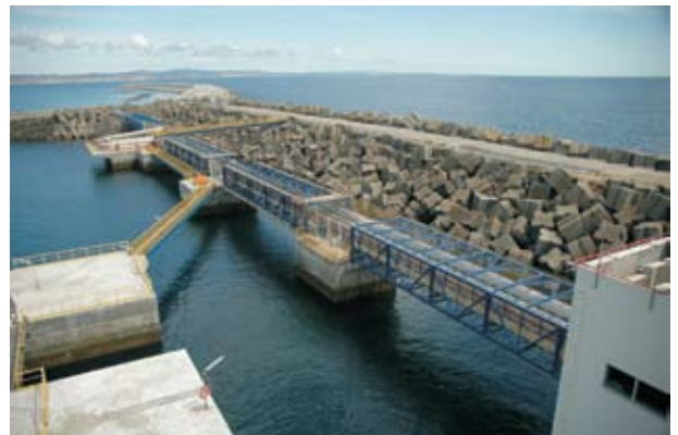
Cais de acostagem de navios do Terminal de GNL de Sines
