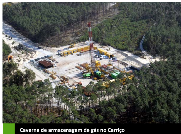
Caverna de armazenagem de gás no Carriço
