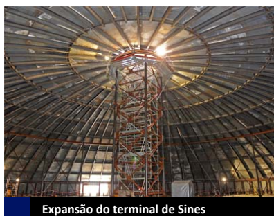
Expansão do terminal de Sines
